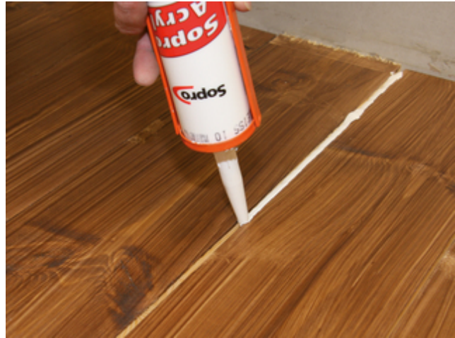
2. Fugen und Löcher sind mit Sopro Dichtacryl zu verschließen.
