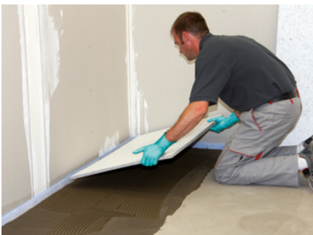
11. Eine Verlegung der Sopro FliesenDämmPlatte mit einem Sopro Flexkleber (z. B. Sopro´s No. 1) zum Auffangen von Bewegungen aus dem Untergrund ist im Anschluss dringend zu empfehlen.
