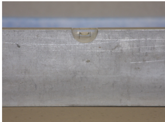
10. Der Sopro FaserFließspachtel ist nach seiner Erhärtung ebenmäßig und verlegebereit.
