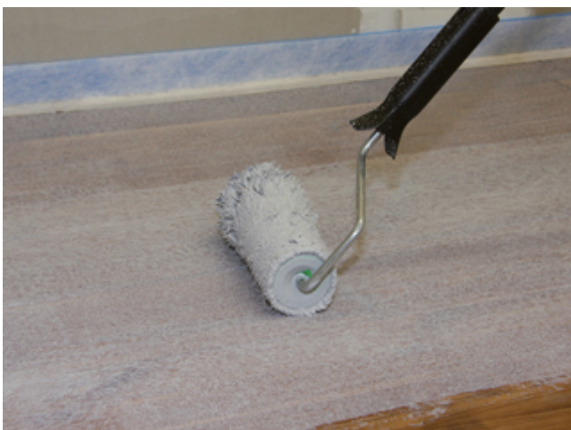
5. Der Holzuntergrund ist mit Sopro HaftPrimer S zu grundieren.
