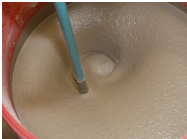
6. Der selbstnivellierende Sopro FaserFließspachtel ist mit einem Rührquirl zu einer homogenen, klumpenfreien Masse anzurühren ...
