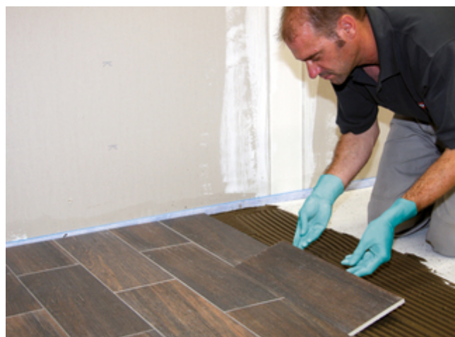
12. Aufziehen eines Sopro Flexklebers (z. B. Sopro's No. 1) und anschließendes Einlegen der Fliesen.
