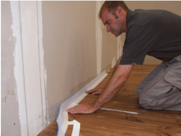
3. Um ein Hinterlaufen der Spachtelmasse zu verhindern, ist der selbstklebende Sopro RandDämmstreifen aufzustellen.
