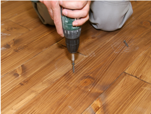
1. Nachverschrauben des sanierungsbedürftigen Holzuntergrundes zur Gewährleistung der Stabilität.
