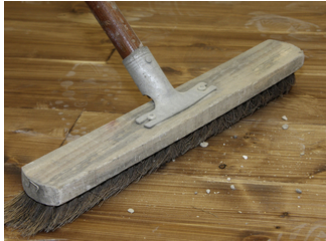
4. Die Fläche ist vor dem Auftrag des Sopro Haftvermittlers ausreichend von haftungsmindernden Stoffen (z. B. Staub) zu befreien.
