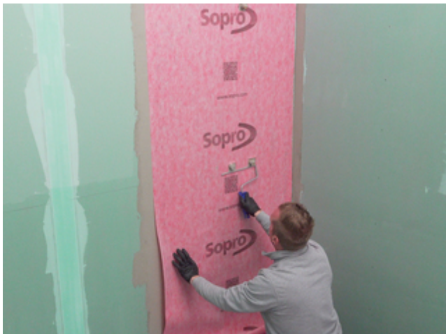
7) Die passgenau zugeschnittene Sopro AEB® Abdichtungs- und EntkopplungsBahn in die frische Klebeschicht einlegen und von der Mitte her fest andrücken.
