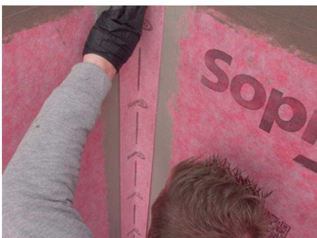
11) Das passgenau zugeschnittene Sopro AEB® Dichtband Flex (mit Falz) ohne Schlaufenbildung in die frische Klebeschicht einlegen und fest andrücken.
