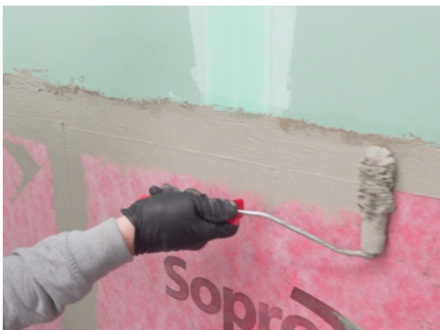
9) Die Abschlüsse der Sopro AEB® Abdichtungs- und EntkopplungsBahn mit Sopro Fixier- & DichtKleber oder Sopro DichtSchlämme Flex RS überarbeiten.
