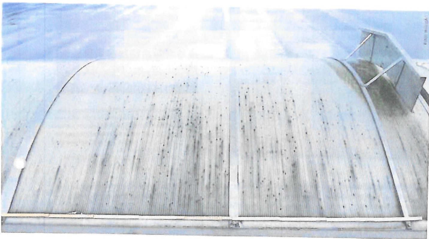
Der Streitpunkt: Lochschäden an Doppelsteg-Lichtplatten
