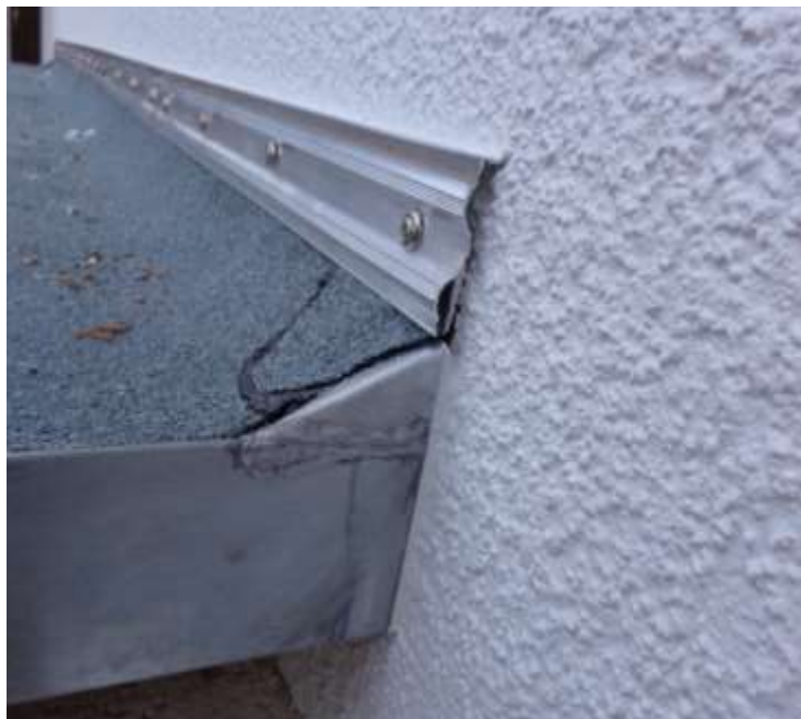
Abbildung 16-17 jeweils Abdichtung des Anschlussprofils (1 x mit Dichtstoff an Dach 1, 1 x ohne an Dach 2 )
