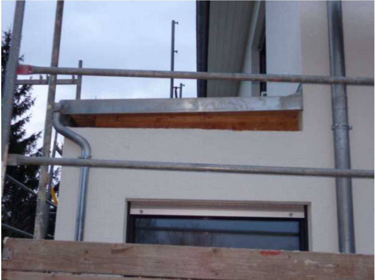
Abbildung 3 Anschluss von Dach, Dachverblechung und (fehlender) Fassade (Anmerkung: Das Anschlussdetail ist mit nicht gesichert bekannt.)
