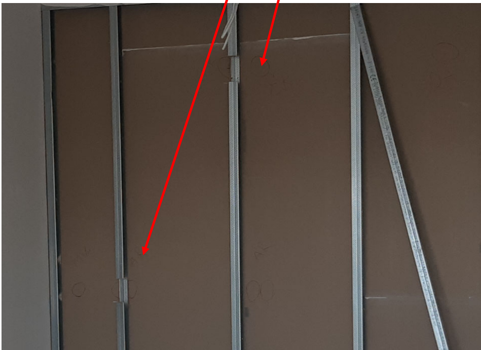
Bereich Leichtbauwand Küche, Schwächung der Längsständer
