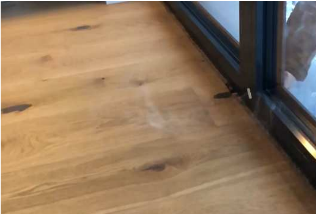
Rauch zieht durch Fugen und Schlitz
