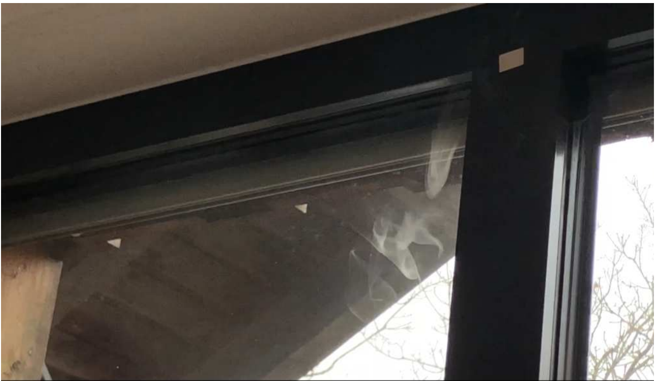
Rauch zieht durch Fugen und Schlitz
