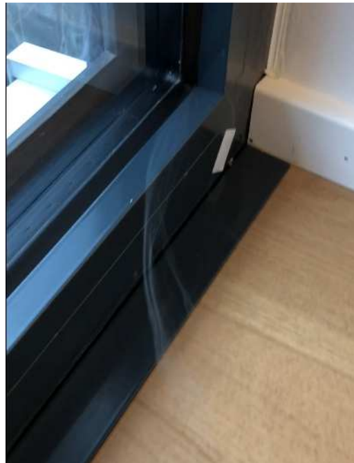
Innenaufnahme: Hoher Temperaturunterschied im unteren Bereich des Fensters
