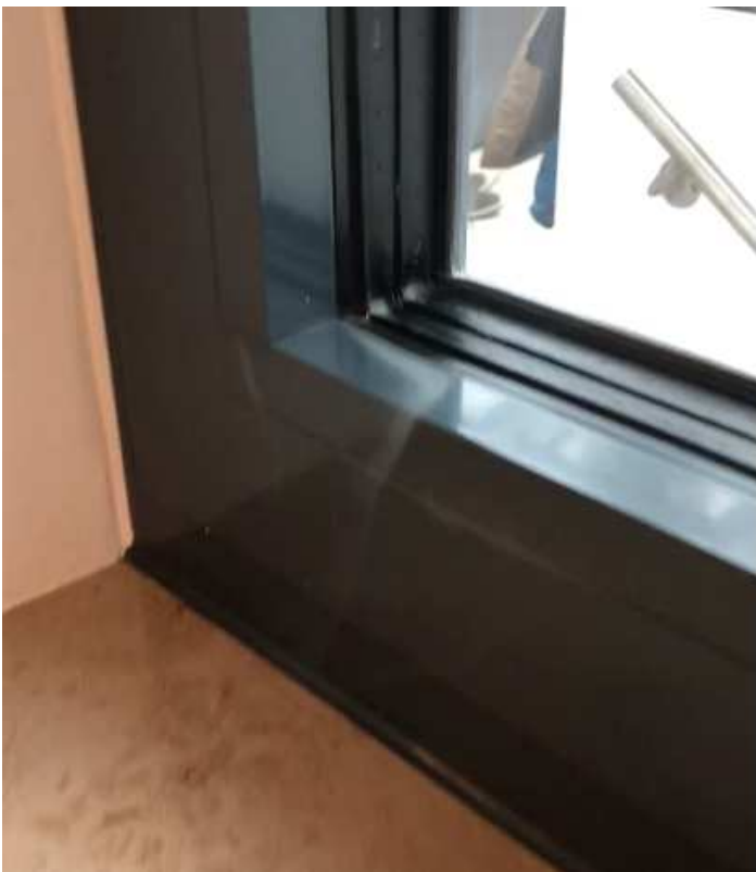
Rauch zieht durch Fugen und Schlitzze
