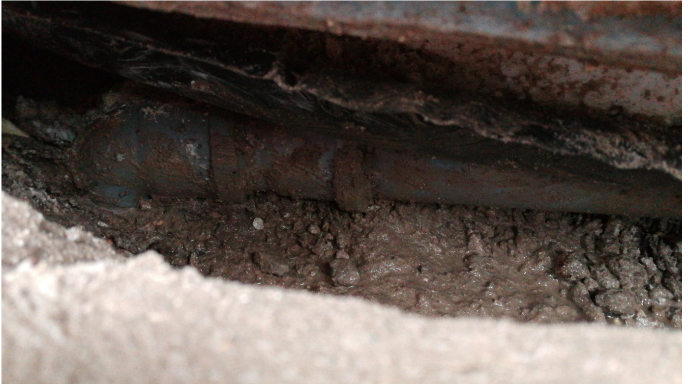
Horizontaler Verlauf der Abwasserleitung unter dem Fenster, Links führt das Rohr zum Anschluss in der Bodenplatte
