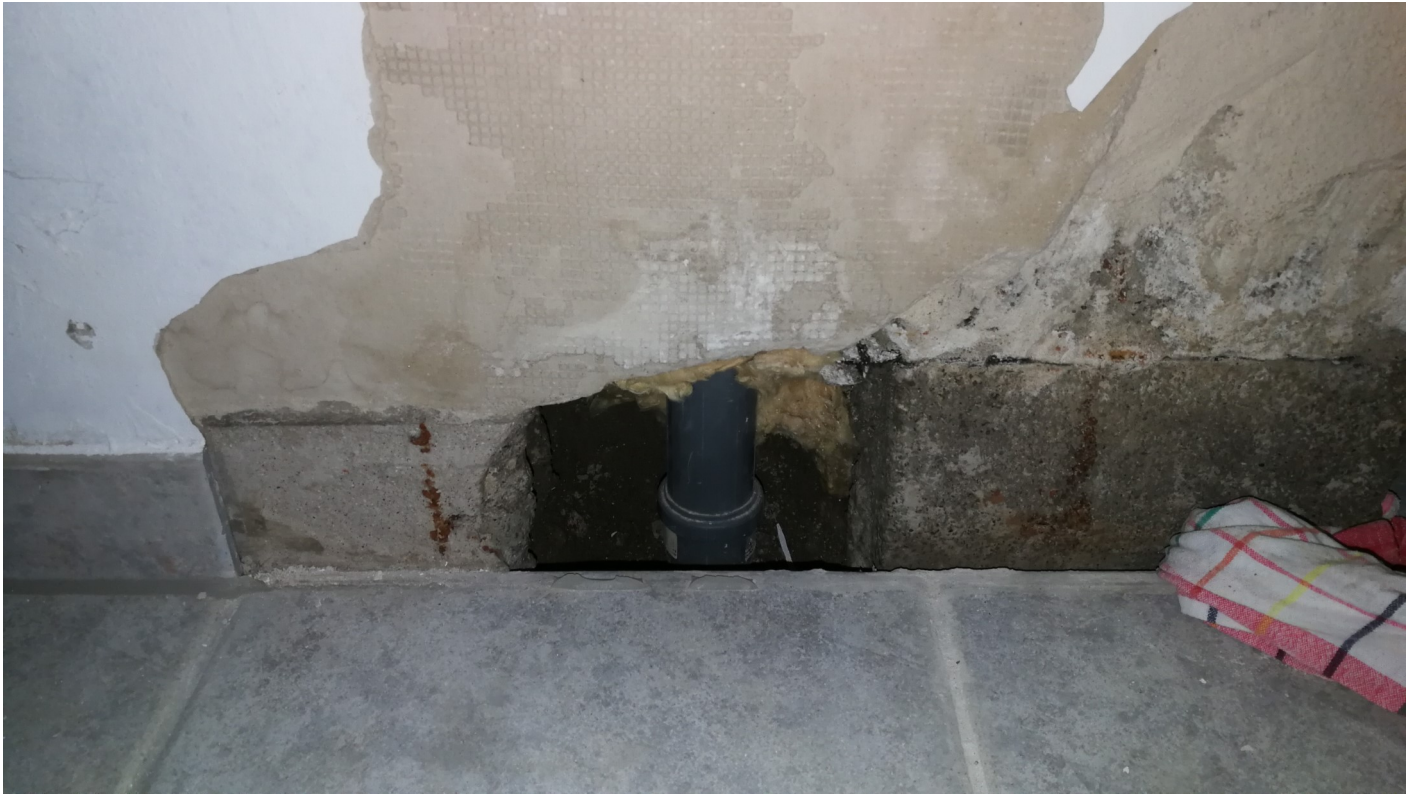
Verlauf der Abwasserleitung von Innen betrachtet, Rohr führt dann nach rechts weg
