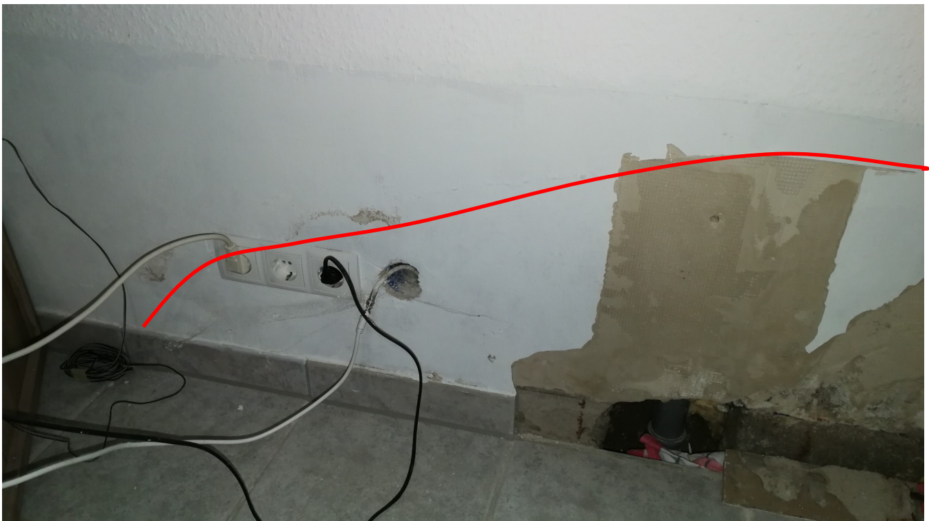
Verlauf der Durchnässung nachgezeichnet
