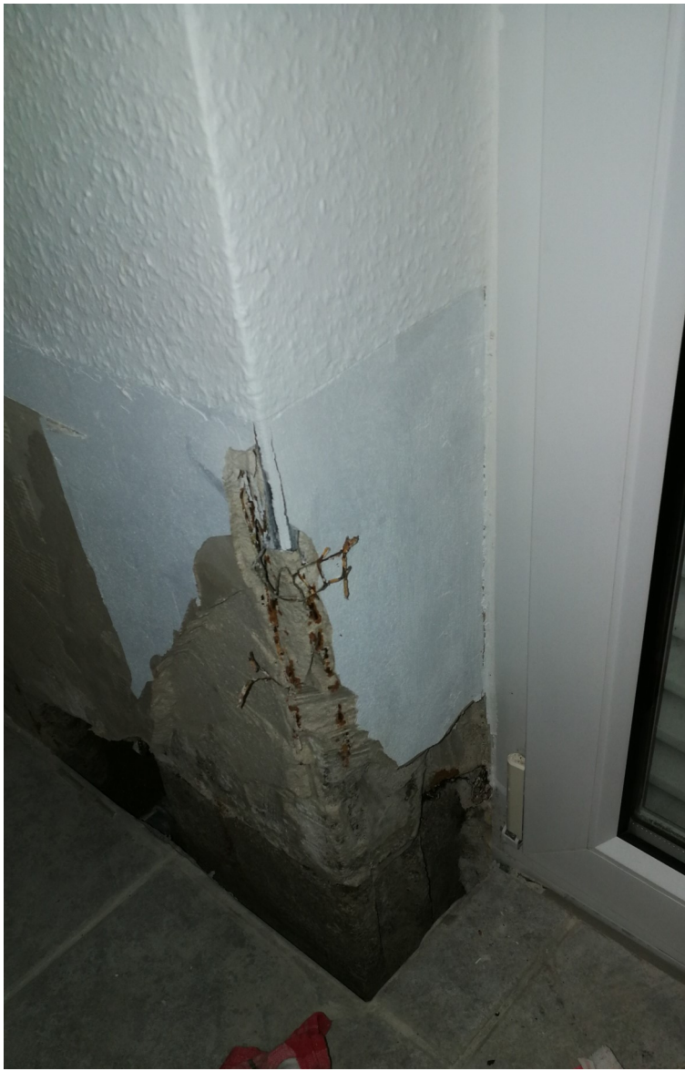
Feuchte Innenwand; durchnässter Putz wurde im Eckbereich entfernt, Die Eckprofile sind bis auf eine Höhe 40cm komplett verrostet gewesen und wurden entfernt, Sockelbereich stark durchnässt, Feuchtemessung ergab 2,4%
