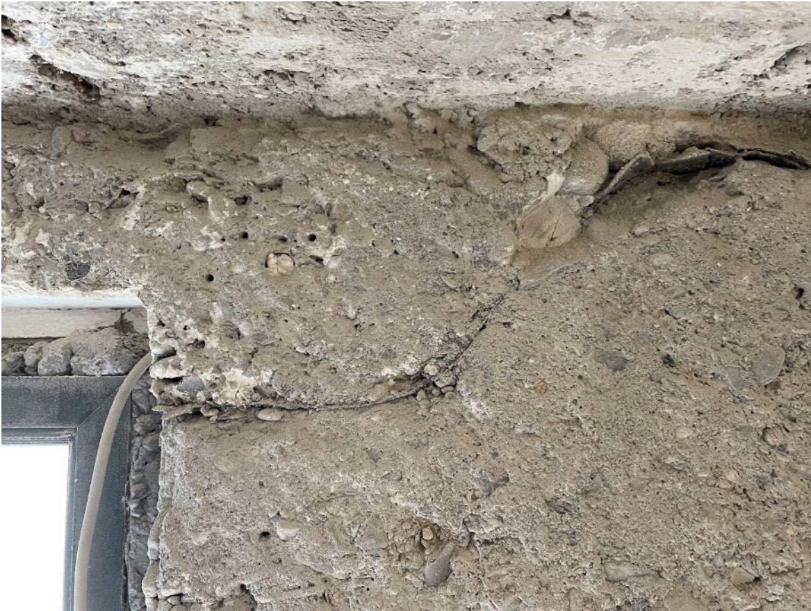
Horizontalsperre (Teerpappe)
