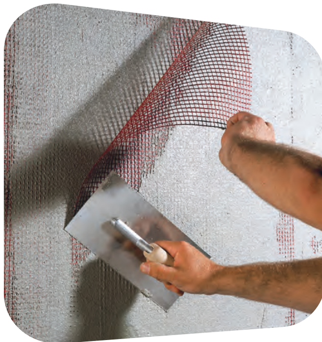
Bild 8: Armierungsputz mit Gewebeeinlage
