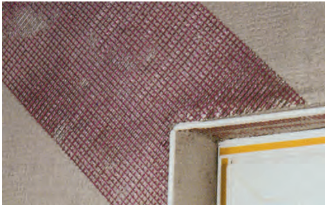
Bild 7: Armierungspfeil an Öffnungsecken
