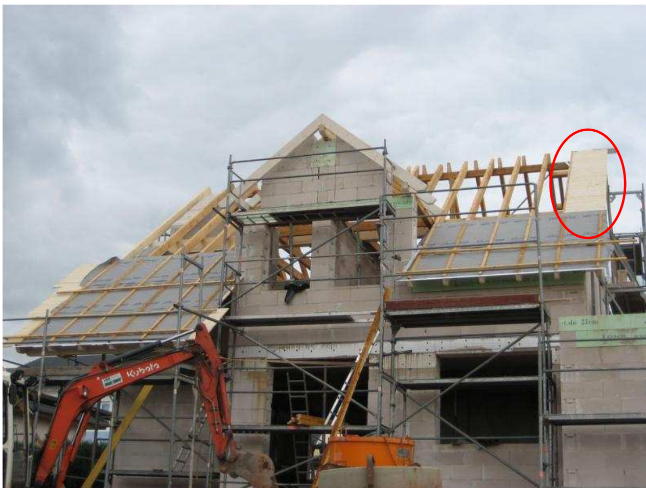
Schalung, Nut+Feder, im ersten Sparrenfeld auf allen Seiten
