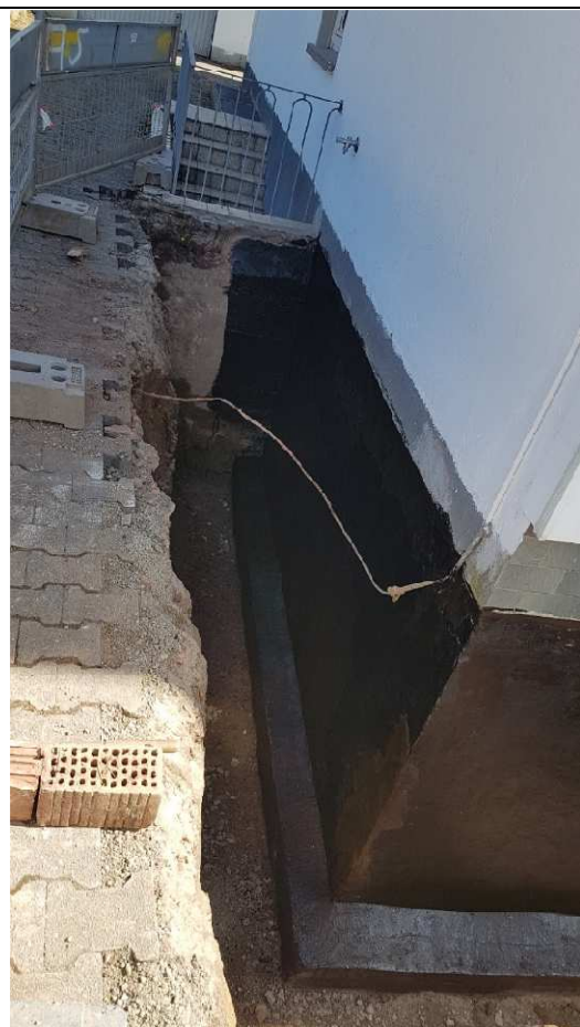
Bild 28: Trockenlegung Außenwand vor Treppenabgang
