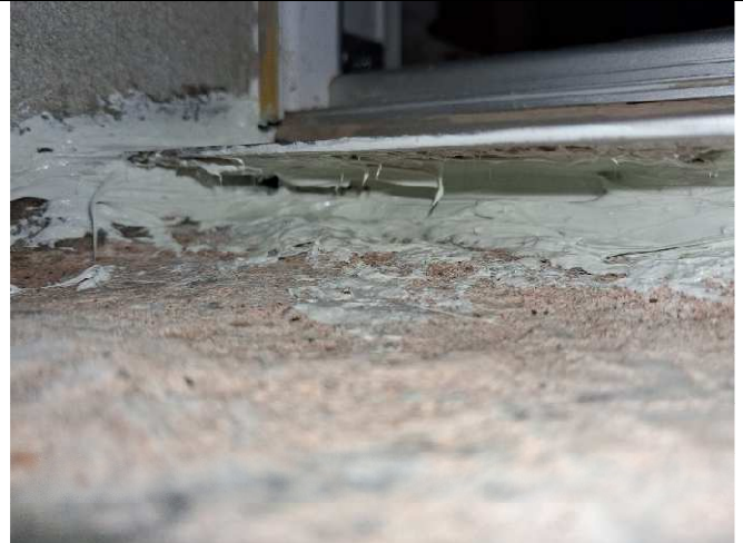
Bild 26: Abdichtung unterhalb Kellertür (links, außen)
