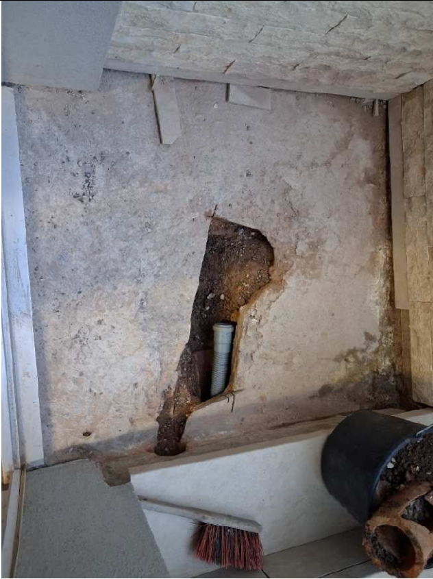
Bild 13: Aufbruch alte Tonleitung mit Inliner
