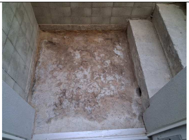
Bild 8: Boden Kellerabgang (Fliesen entfernt)
