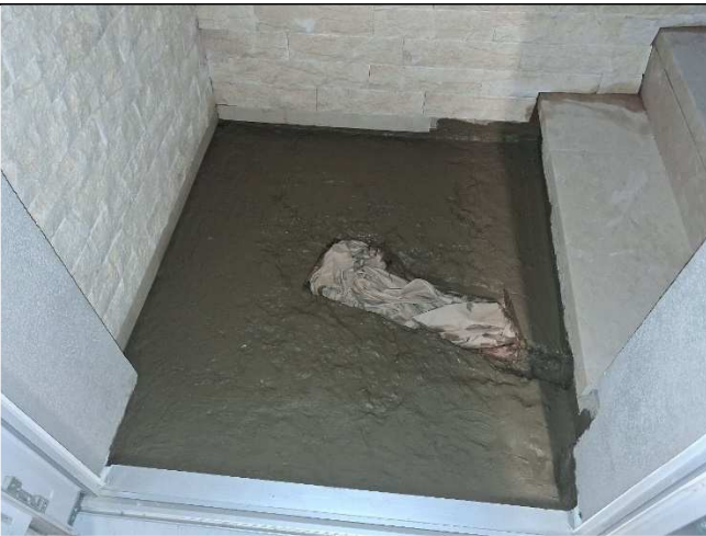
Bild 15: Dichtschlämme auf alter Betonoberfläche
