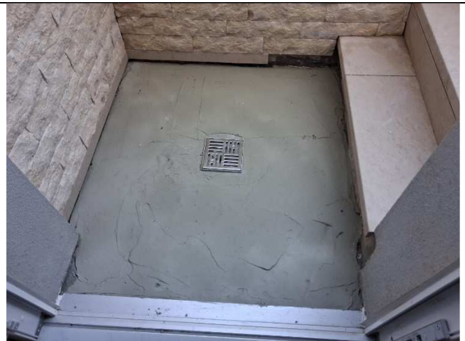
Bild 16: einbetonierter Duschablauf
