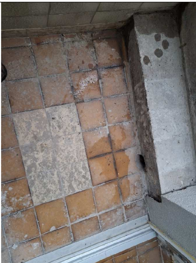
Bild 7: Boden Kellerabgang mit Entwässerungsöffnung
