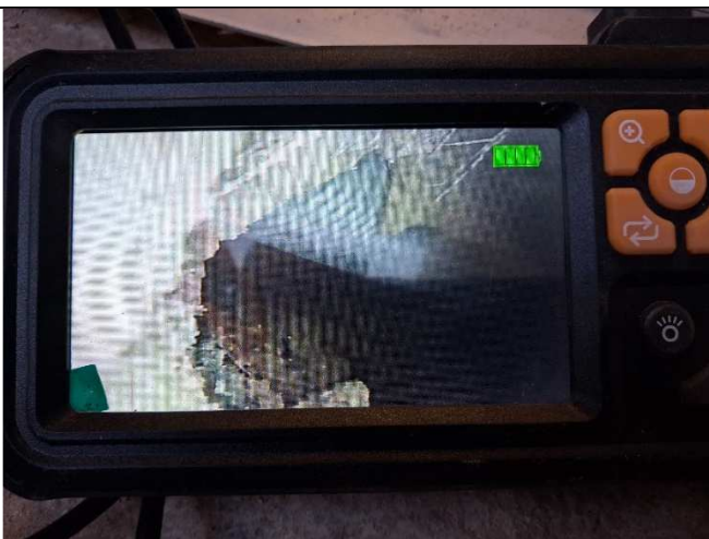
Bild 27: Inliner in Tonleitung
