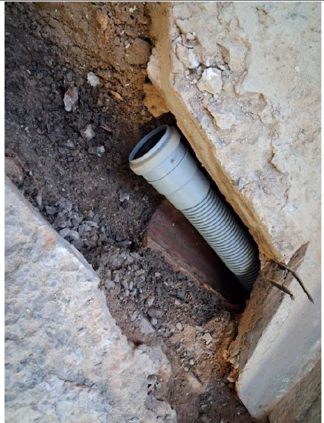
Bild 14: Inliner (Flexrohr) in Tonleitung
