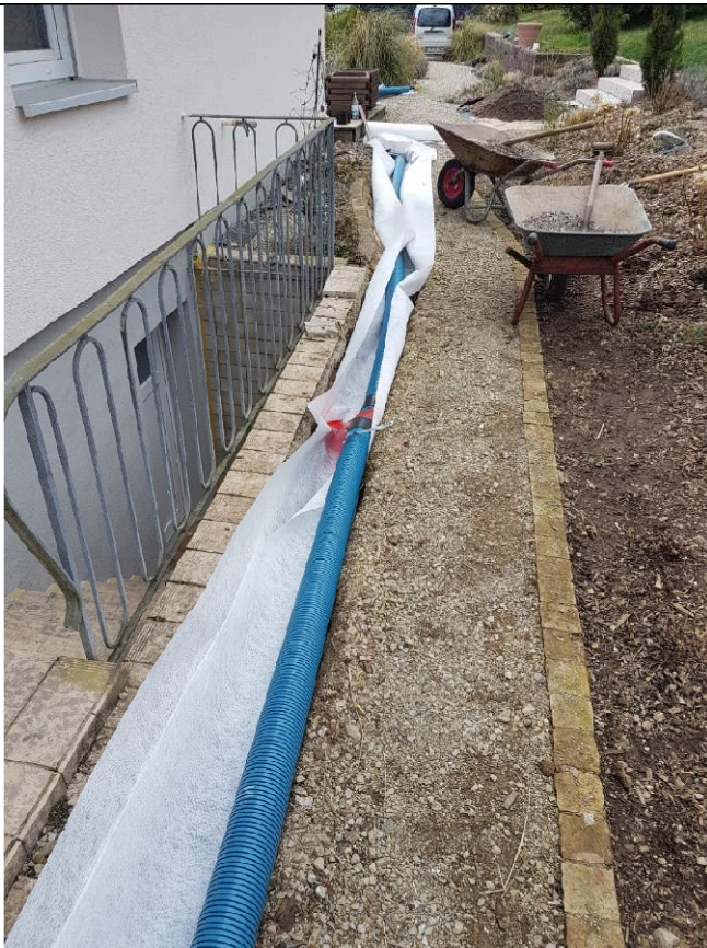
Bild 3: nachträglicher Einbau Drainage
