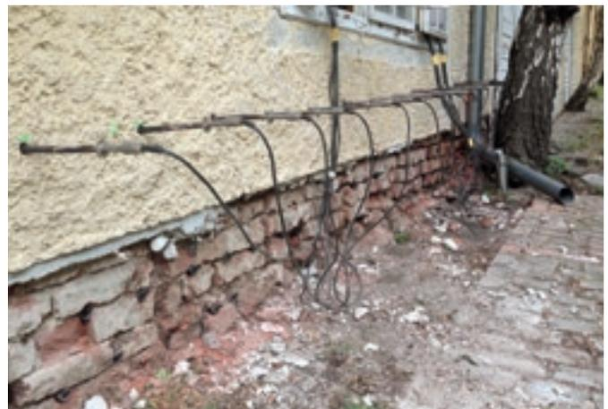
■ Heizstabtrocknung nach erfolgter Horizontalinjektion
