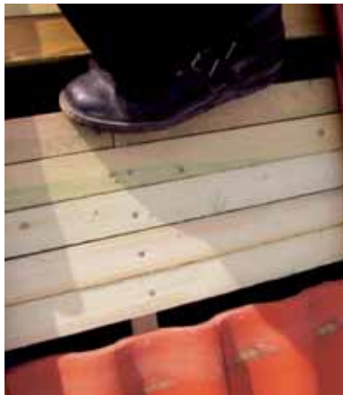
Nicht funktionsfähig: Nebeneinander liegende Dachlatten sollten Stabilität in die Konstruktion bringen
