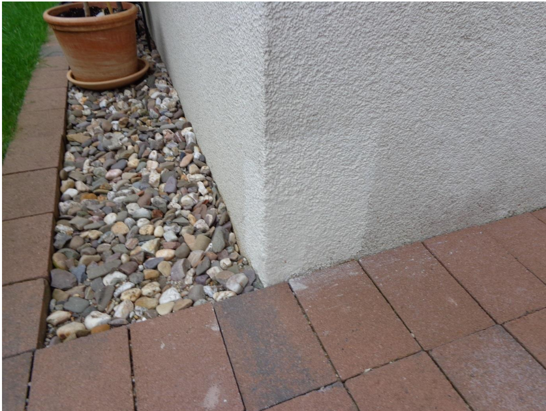
Nachbesserung von Beschädigungen an einer Außenecke.
