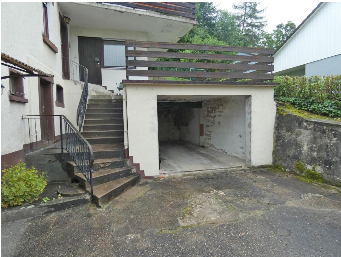
Garage und Treppenaufgang
