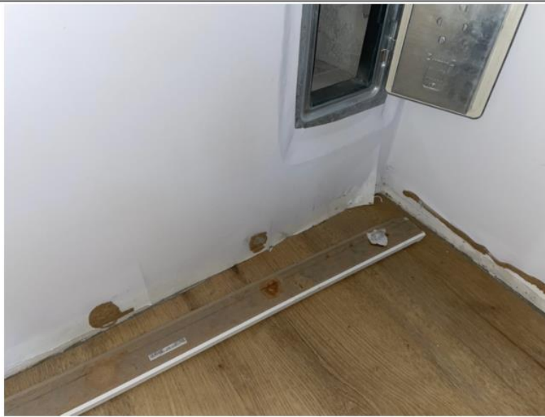
Fußleisten sind verschimmelt
