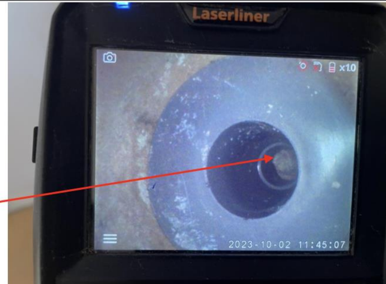
Mörtel im Ablauf sichtbar
