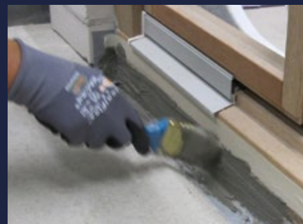
Abdichten der Fuge mit Sopro TurboDichtSchlämme 2-K.
