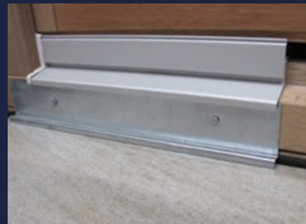
Die Fliesenverlegung erfolgt im Dünnbettverfahren mit Sopro megaFlex S2. Zum Türelement hin erfolgt der Abschluss mit einer Schiene.
