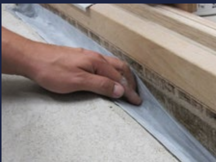
Einkleben des Sopro FlexDichtBandes in die abzudichtende Fuge.
