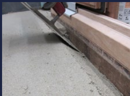
Abstellen des Estrichs oder Gefällepachtels im Winkel von 45° vor dem Türelement.
