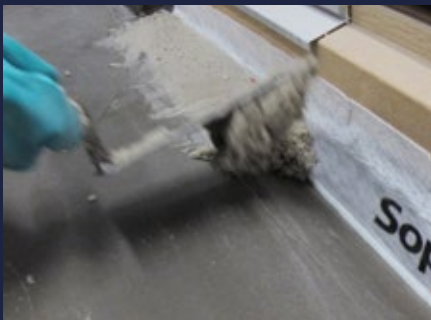
Nach dem Einstellen eines Randdämmstreifens wird die Vertiefung mit einem schwindarmen und kapillardichten Reaktionsharzmörtel verfüllt.
