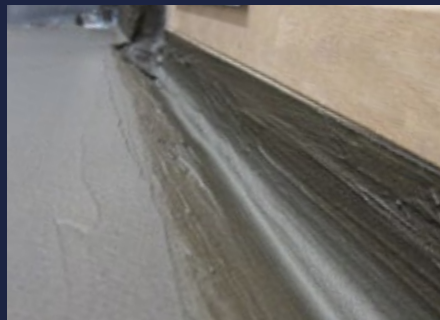
Abgedichtete Balkonfläche mit Anschluss an das Türelement.
