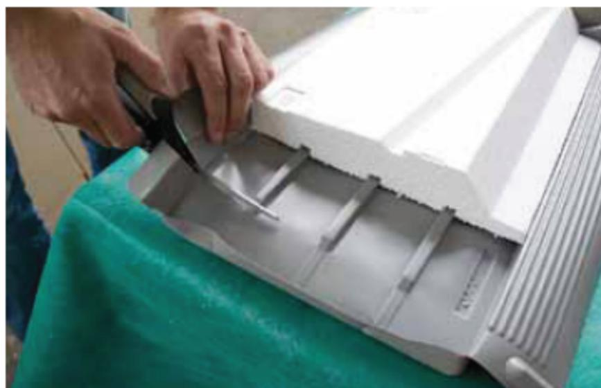
Anschlüsse z.B. an Dachfenster oder aufgehende Wände können durch das Kürzen der ‚Protect‘ Elemente hergestellt werden. Hierbei wird die Polystyrol-Dämmung aus der Folienschale entnommen und auf das erforderliche Maß geschnitten.
