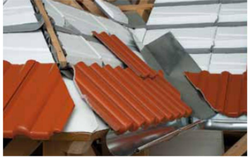
Die Wasserführung in Dachkehlen kann mit einem untenliegenden Blech oder mit einer Kehlfolie auf den ‚Protect‘ Elementen ausgeführt werden.
