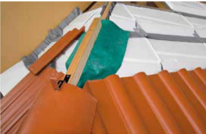
Beim Anarbeiten der ‚Protect‘ Elemente an den Grat ist ähnlich zu verfahren wie bei seitlichen geraden Anschlüssen .
