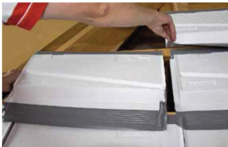
Die ‚Protect‘ Dämmelemente werden im Versatz oder linear von rechts nach links (wie die Ziegeleindeckung) verlegt. Es hat sich bewährt, die Dachziegel gleichzeitig mit den ‚Protect‘ Elementen linear von Traufe zu First einzubauen.
