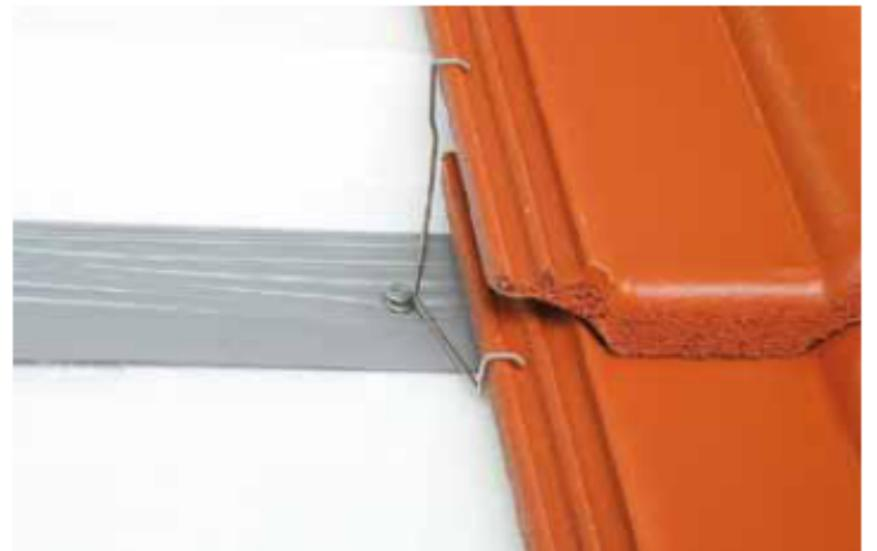
Die Wind-Sog-Sicherung der Dachziegel erfolgt mit Original Thermodach Sturmklammern [Thermodach Zubehör] auf die untenliegende Dachlatte. Die benötigte Anzahl ist gemäß Regelwerk des Deutschen Dachdeckerhandwerks zu ermitteln.
